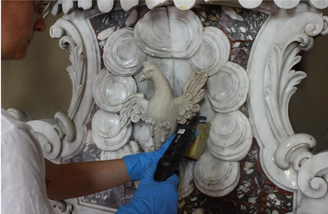
Dopo l'impacco e il risciacquo, la pulitura viene perfezionata con l'ausilio del vapore a bassa pressione.
