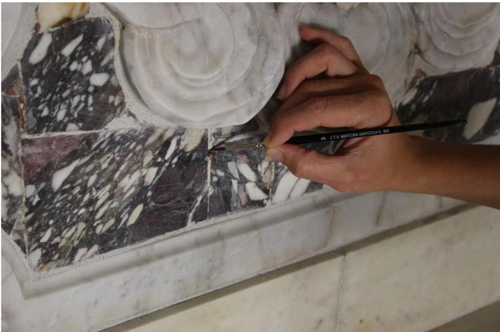
Il ritocco delle microstuccature sulle tarsie in breccia medicea è stato condotto “spezzando” cromaticamente le linee bianche con le tonalità presenti nel marmo.
