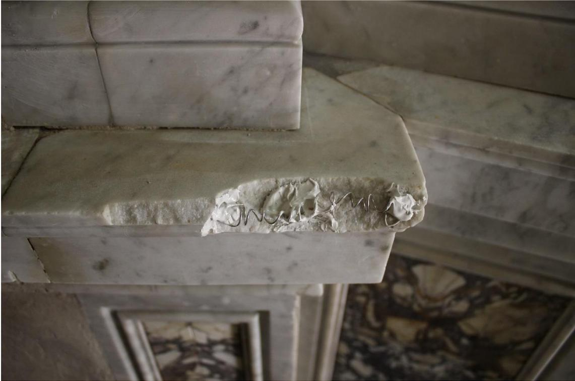
Dove la morfologia della lacuna non offriva un adeguato sostegno alla malta d'integrazione, sono stati realizzati dei rinforzi in fili di acciaio inox e resina epossidica bicomponente.
