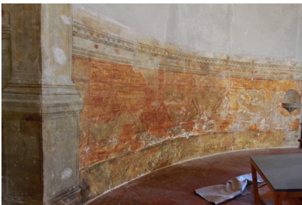
Affreschi della navata: operazioni di stuccatura e ritocco pittorico prima e dopo il restauro
