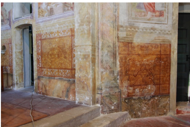
Affreschi del presbiterio: operazioni di stuccatura e ritocco pittorico prima e dopo il restauro
