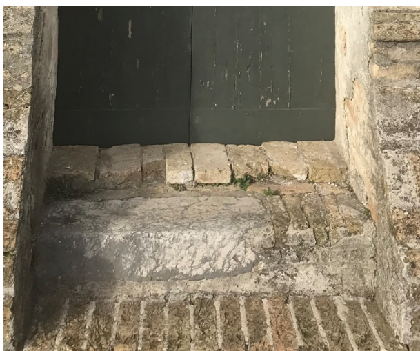
Dettaglio del deposito di particolato atmosferico nella pietra e nell'intonaco
