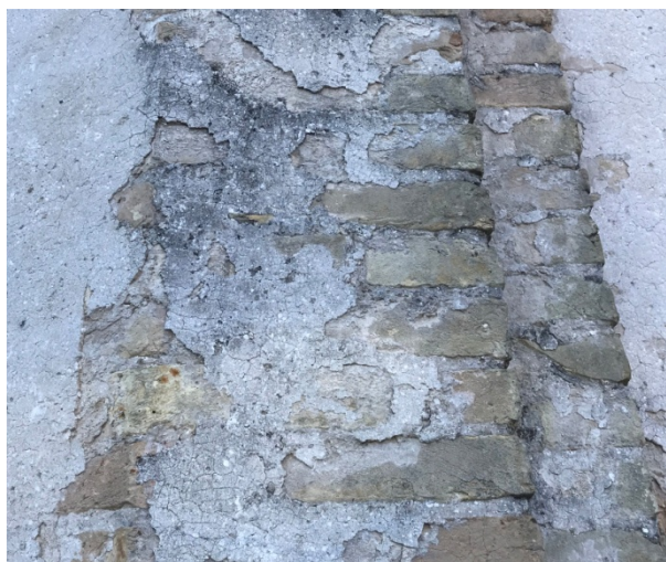
Dettaglio del deposito di particolato atmosferico nella pietra e nell'intonaco
