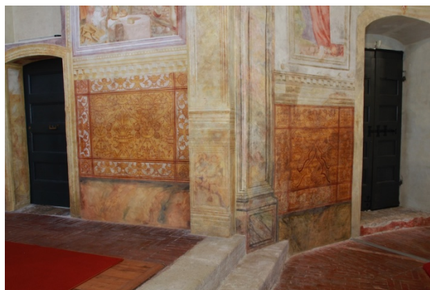
Affreschi del presbiterio: operazioni di stuccatura e ritocco pittorico prima e dopo il restauro
