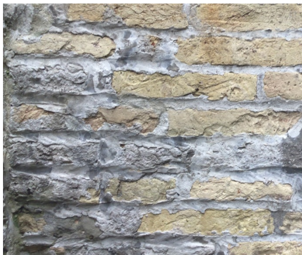
Dettaglio della avvenuta pulizia del deposito di particellato atmosferico e delle pattine biologiche nella muratura in mattoni
