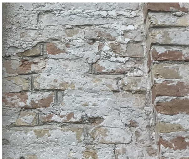
Dettaglio della avvenuta pulizia del deposito di particellato atmosferico nella pietra e nell'intonaco
