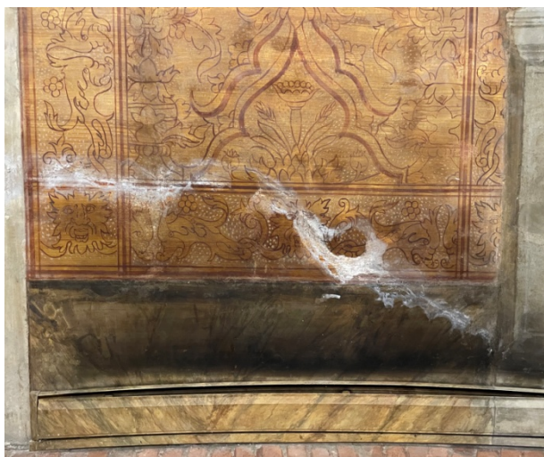
Dettaglio paramento murario interno con e senza battiscopa impianto di riscaldamento
