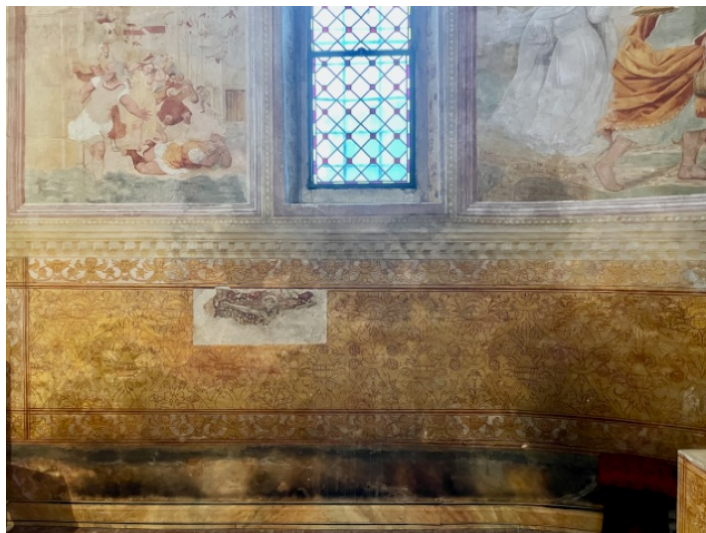
Affreschi del presbiterio: stato prima del restauro, nerofumo di fuoriuscita dalle canaline del riscaldamento
