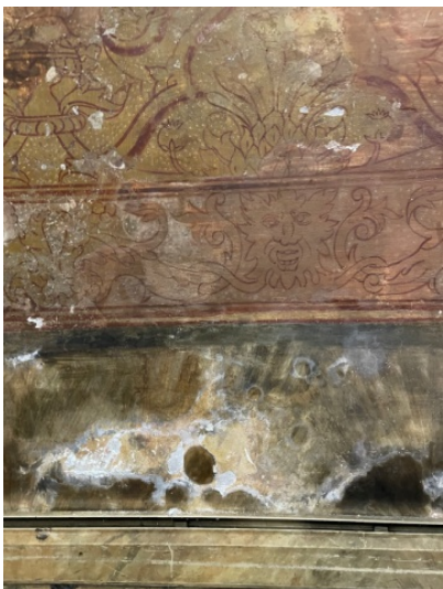
Affreschi della navata: stato prima del restauro, a sinistra dettaglio di nerofumo e sali con la canalina di riscaldamento, a destra rimozione canalina di riscaldamento
