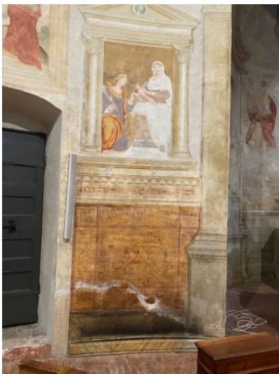
Affreschi della navata: stato prima del restauro con e senza canalina di riscaldamento
