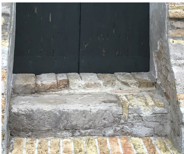
Dettaglio della avvenuta pulizia del deposito di particellato atmosferico nella pietra e nell'intonaco
