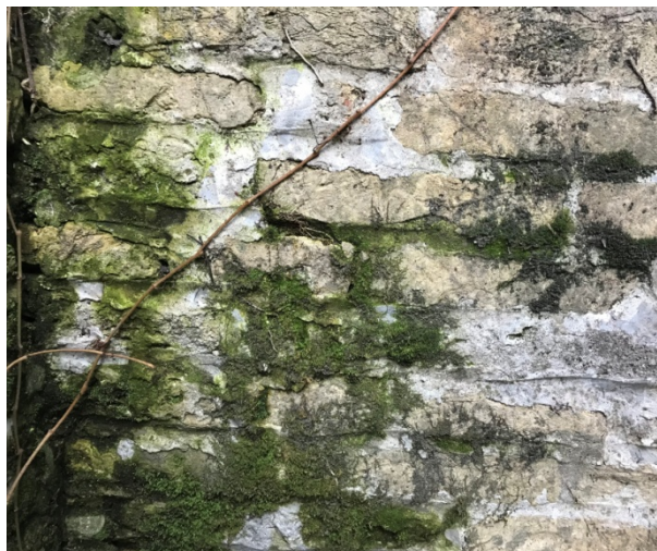
Dettaglio del deposito di particolato atmosferico e delle pattine biologiche nella muratura in mattoni
