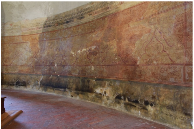
Affreschi della navata: stato prima del restauro, a sinistra dettaglio di nerofumo e sali con la canalina di riscaldamento, a destra rimozione canalina di riscaldamento
