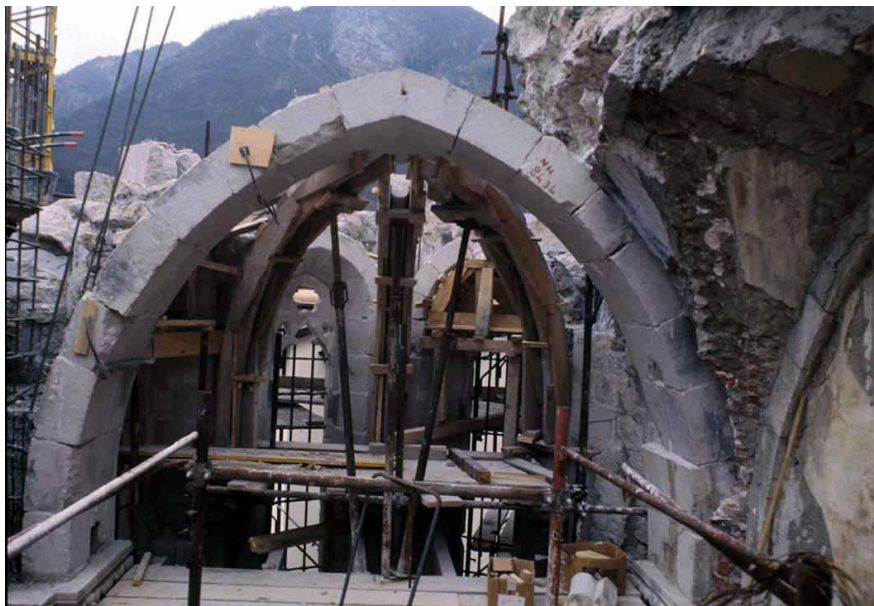
Duomo di Venzone durante il cantiere: ricomposizione dell'abside nord (foto: A.Quendolo)
