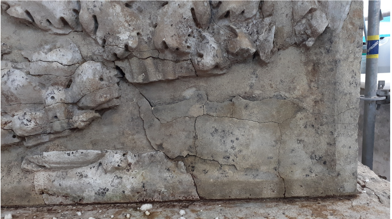
Foto 7 Latonord. Le fessurazioni e i distacchi compromettevano anche le ricostruzioni in stucco cementizio
