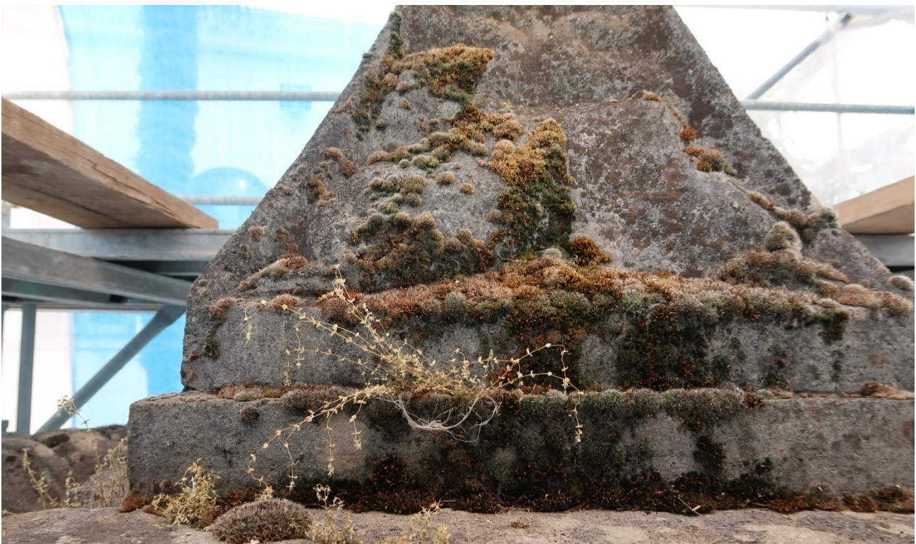
Foto 10 La cuspidale piramidale dopo l'applicazione del biocida che ha provocato il rinsecchimento di muschio e della vegetazione erbacea
