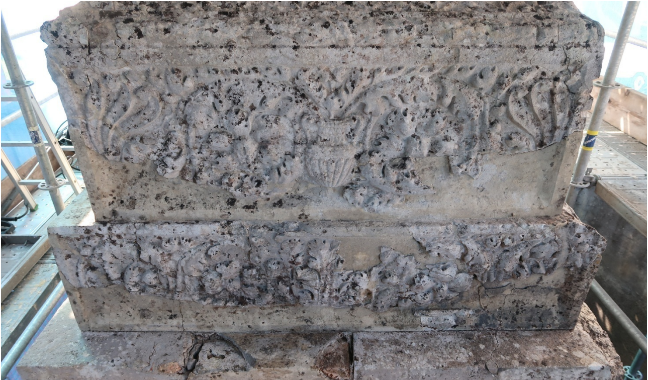
Foto 13. Lato nord. In corrispondenza del lato nord il livello di pulitura raggiunto dopo il primo idrolavaggio risultava insufficiente
