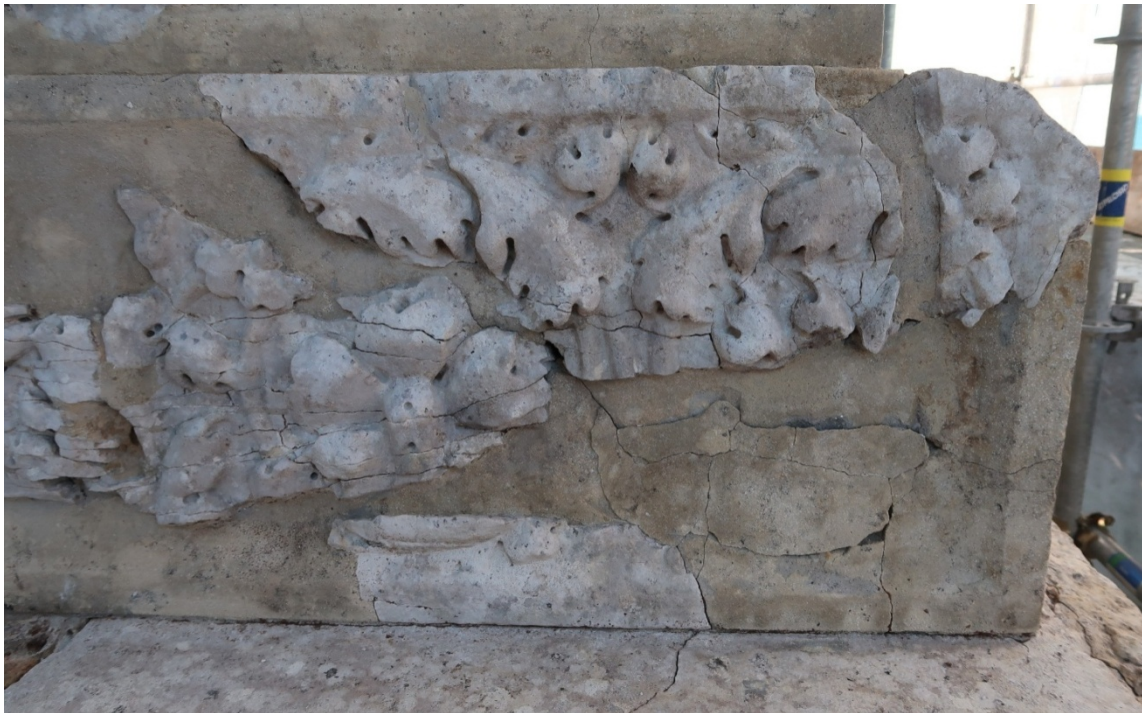
Foto 21 Lato nord. Dopo la pulitura e il consolidamento
