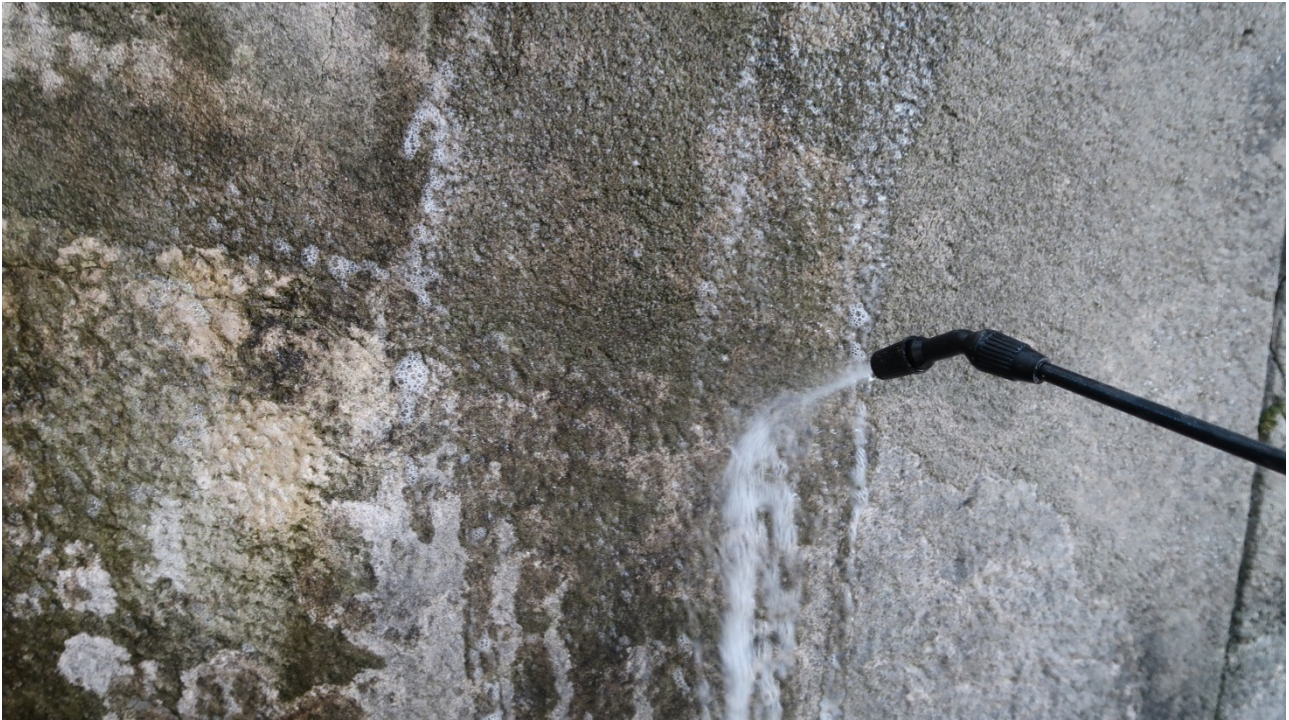
Foto 9 Lato nord durante la fase di applicazione del biocida
