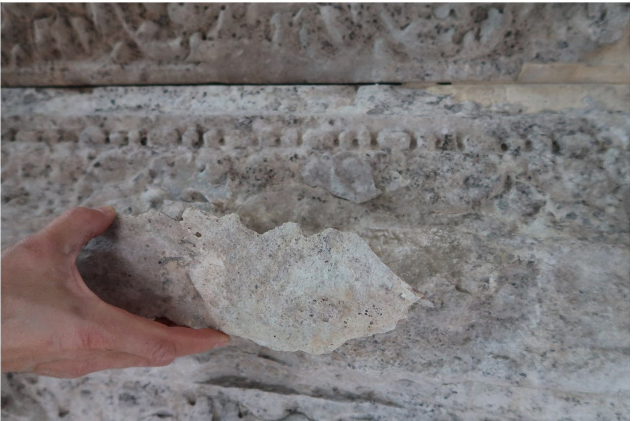
Foto 6 Latoest. I distacchi interessavano anche superfici caratterizzate da modellato scultoreo
