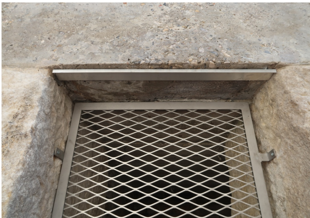
Foto 24 Lato ovest. L'ingresso alla cella funeraria con la ricostruzione dell'architrave, la nuova grata in acciaio inox e il gocciolatoio
