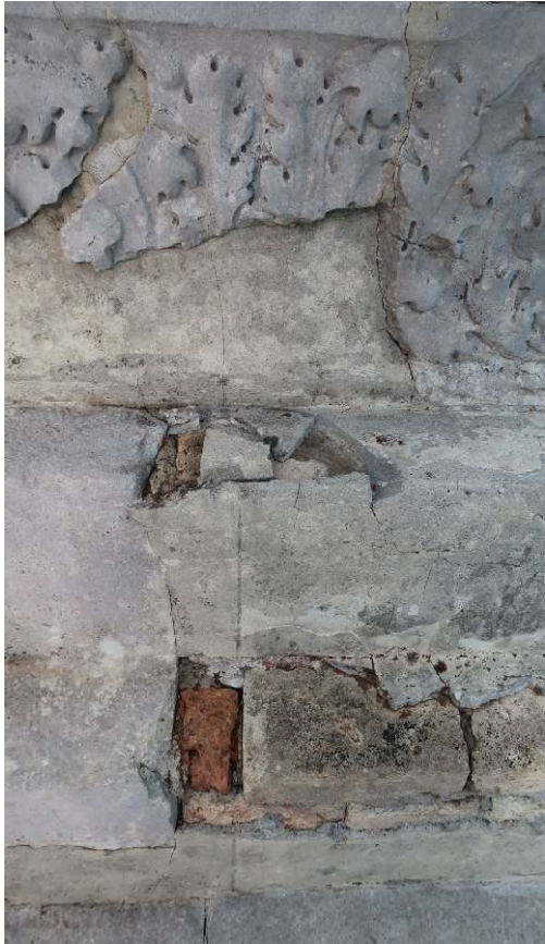
Foto 18 Lato est. Dopo la pulitura e il consolidamento
