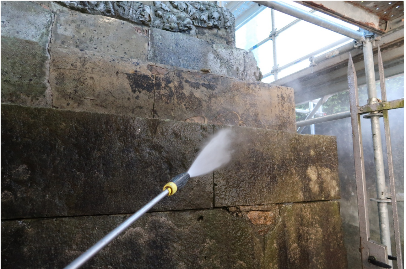
Foto 11 Lato nord. Le superfici sono state pulite con un primo idrolavaggio a pressione controllata
