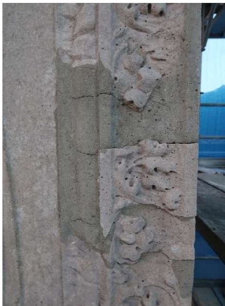
Foto 20 Lato est. Dopo la pulitura e il consolidamento
