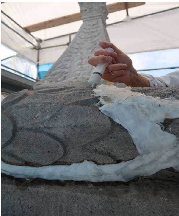
Foto 16 Cuspide piramidale. I consolidamenti sono stati eseguiti per risolvere il quadro fessurativo, con differenti prodotti a seconda del tipo di fessurazione e dell'entità del distacco. Per sigillare le larghe fessure che erano state lasciate aperte dopo il rimontaggio degli anni '50 sono state utilizzate iniezioni di maltine fluide previa realizzazione di tasche in argilla.
