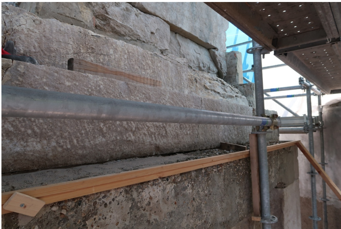
Foto 17 Lato ovest. È stato rinnovato il rivestimento della trave in cemento armato poiché totalmente compromesso. La nuova stesura in malta idraulica è stata realizzata in leggera pendenza per favorire lo smaltimento delle acque meteoriche e scongiurare la possibilità di nuove infiltrazioni
