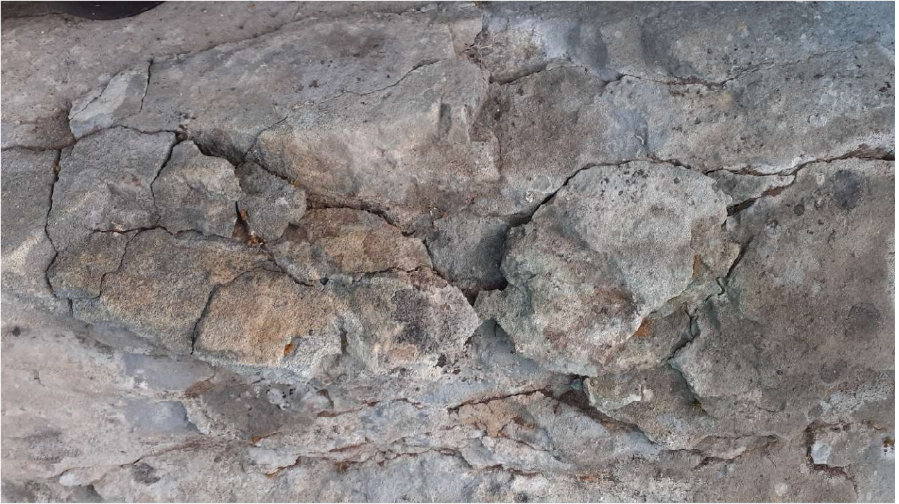
Foto 5 Latoovest. In diversi punti i lapidei risultavano superficialmente fessurati e distaccati
