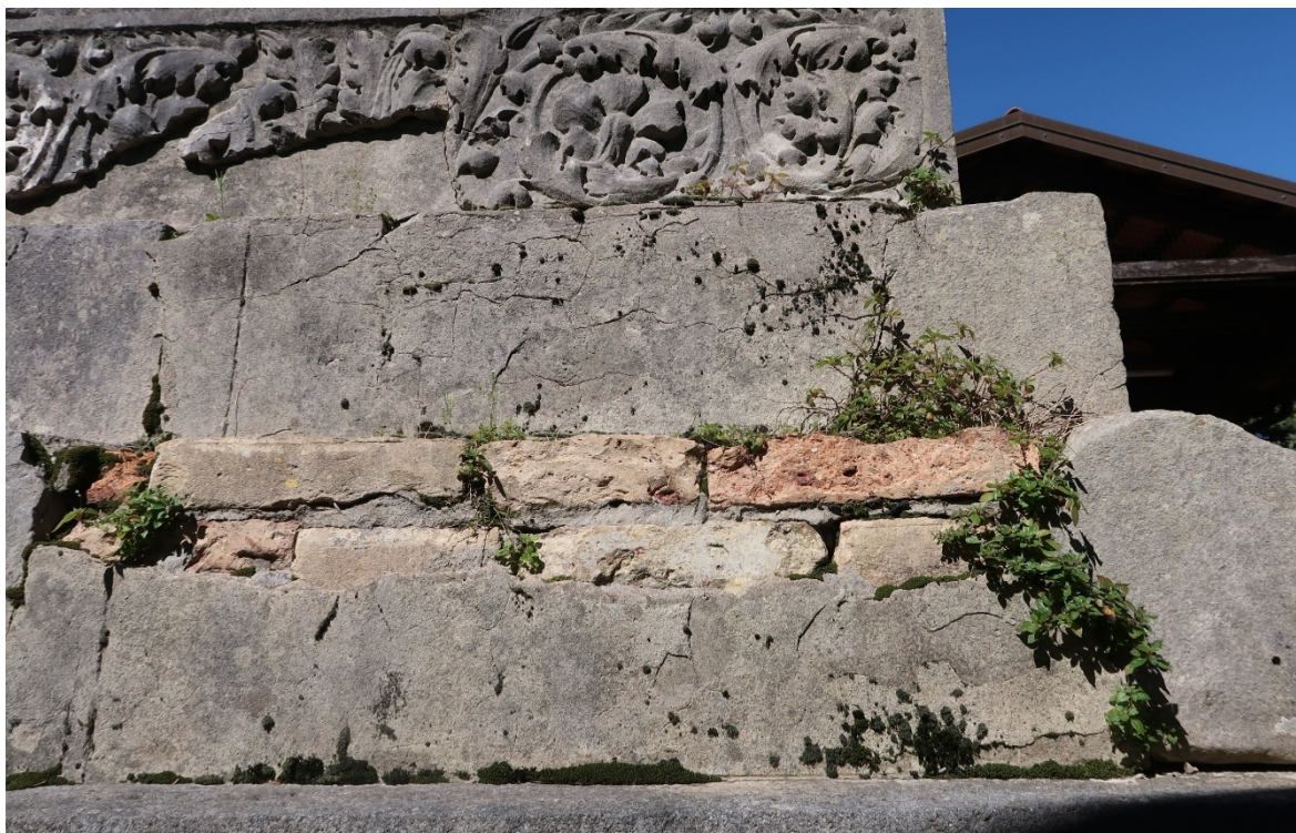
Foto 3 Lato sud. Lo stato conservativo prima dell'intervento: presenza di colonizzazione lichenica e algale su tutte le superfici, crescita di muschi e vegetazione erbacea, perdita parziale del rivestimento in stucco cementizio che ricopriva le integrazioni in mattoni.
