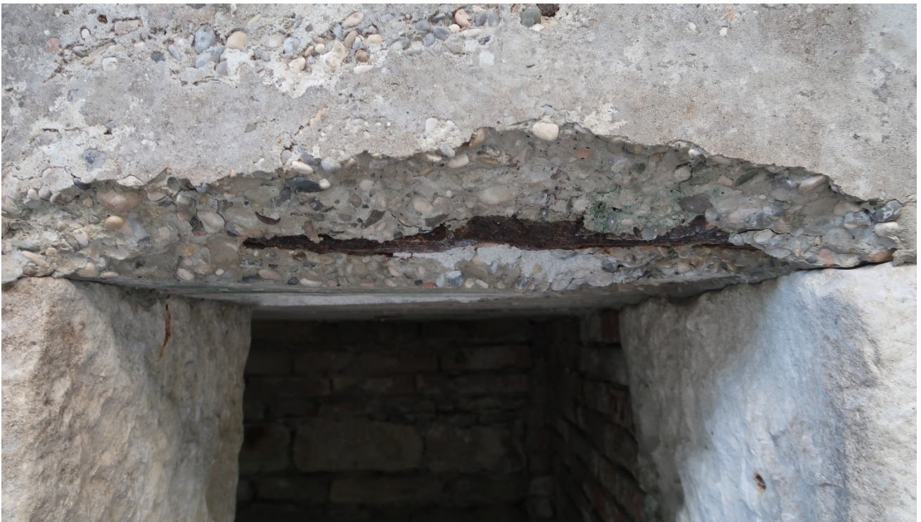
Foto 8 Lato ovest. Le infiltrazioni d'acqua hanno portato all'ossidazione dei ferri dell'armatura della trave in cemento armato con conseguente caduta di parte della porzione di spigolo.
