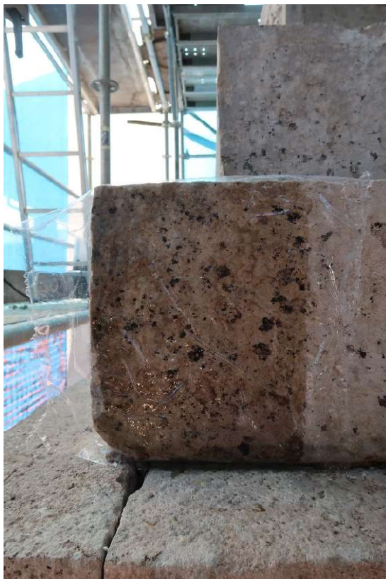
Foto 13. Lato nord. In corrispondenza del lato nord il livello di pulitura raggiunto dopo il primo idrolavaggio risultava insufficiente
