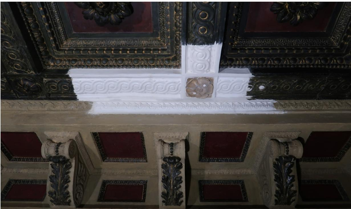
Foto 22. I segmenti sono stati montati a soffitto, stuccati e policromati
