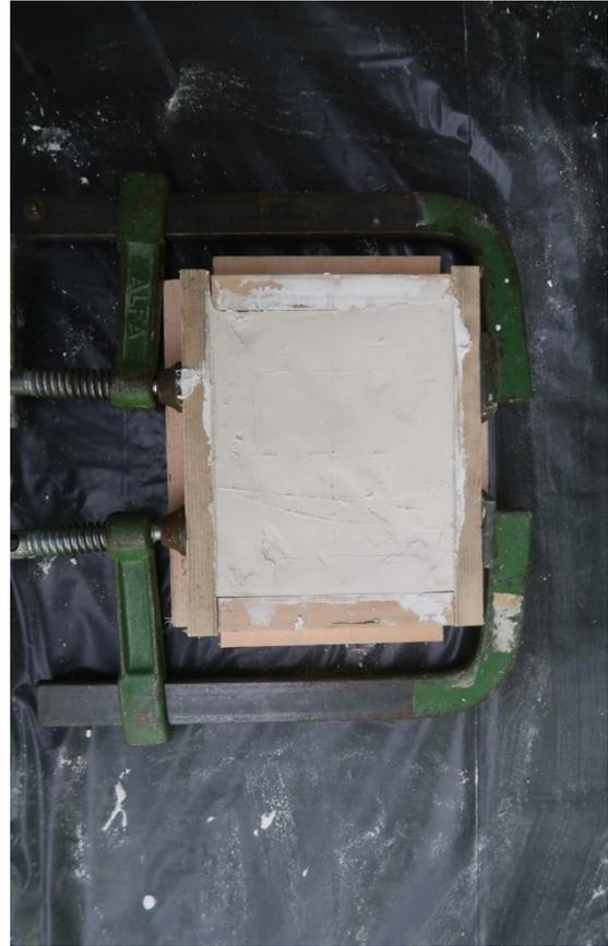
Foto 21 e 22. A banco, entro cassetine di contenimento sono state realizzati i segmenti di cornice mancanti con colate di gesso.
