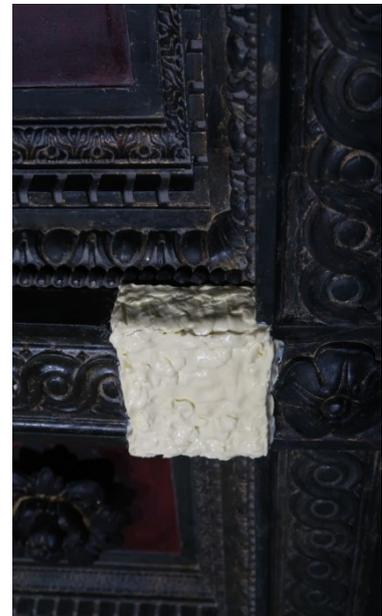
Foto 19 e 20. Per poter integrare le parti di cornici in gesso mancanti è stato necessario prendere il calco in gomma silconica delle zone integre.
