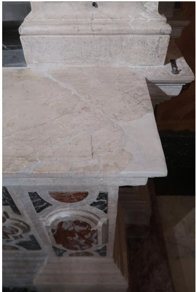
Foto 29 e 30. I frammenti sono stati incollati, le parti mancanti sono state ricostruite e poi stuccate.
