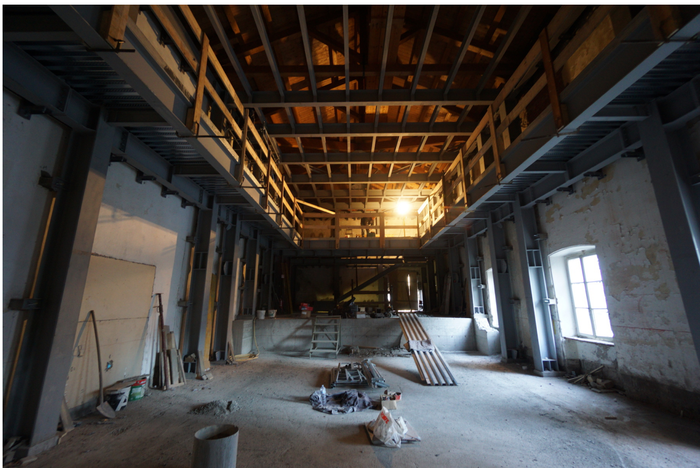
Costruzione del piano balconata
