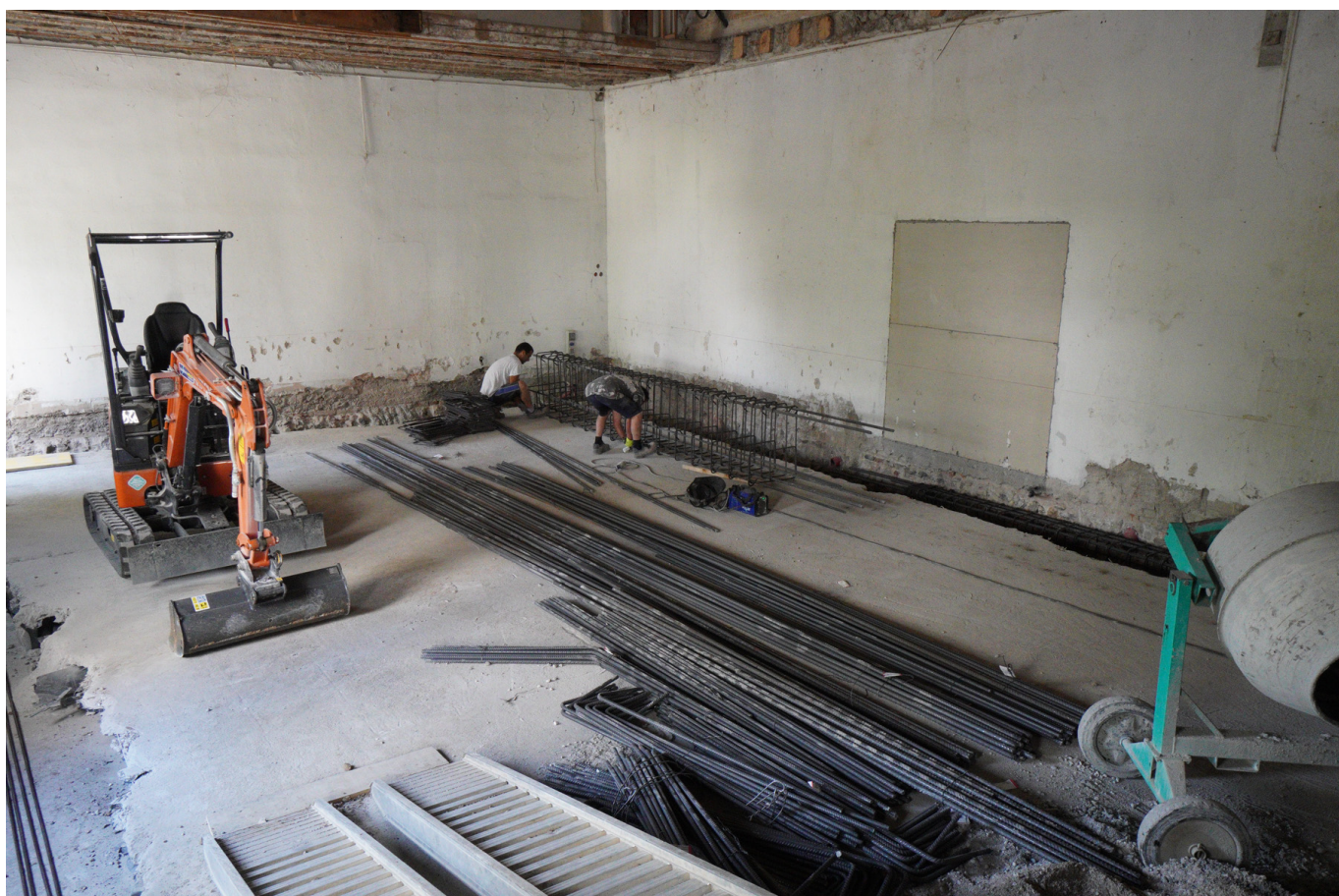
Lavori in fondazione (sottomurazione)
