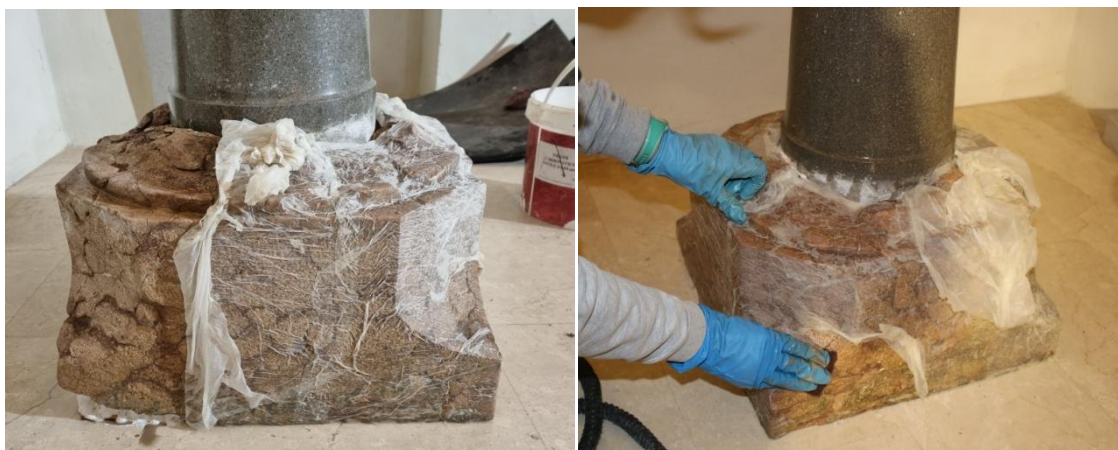
In alto, la rimozione dell'impacco di E.D.T.A. sul basamento. Sotto, l'impiego del vaporizzatore sul catino.
