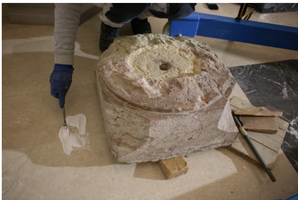
Nell'immagine la stesura del letto di colla bicomponente sul pavimento.
