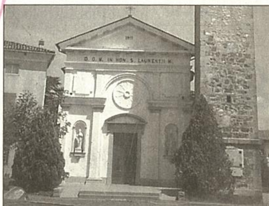
E' stata restaurata la facciata della chiesa di Cerneglons
