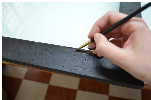
Stuccatura e ritocco delle lacune del legno
