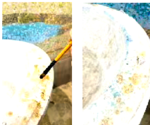
foto dell'estrazione di macchie di ossido di rame e ferro
