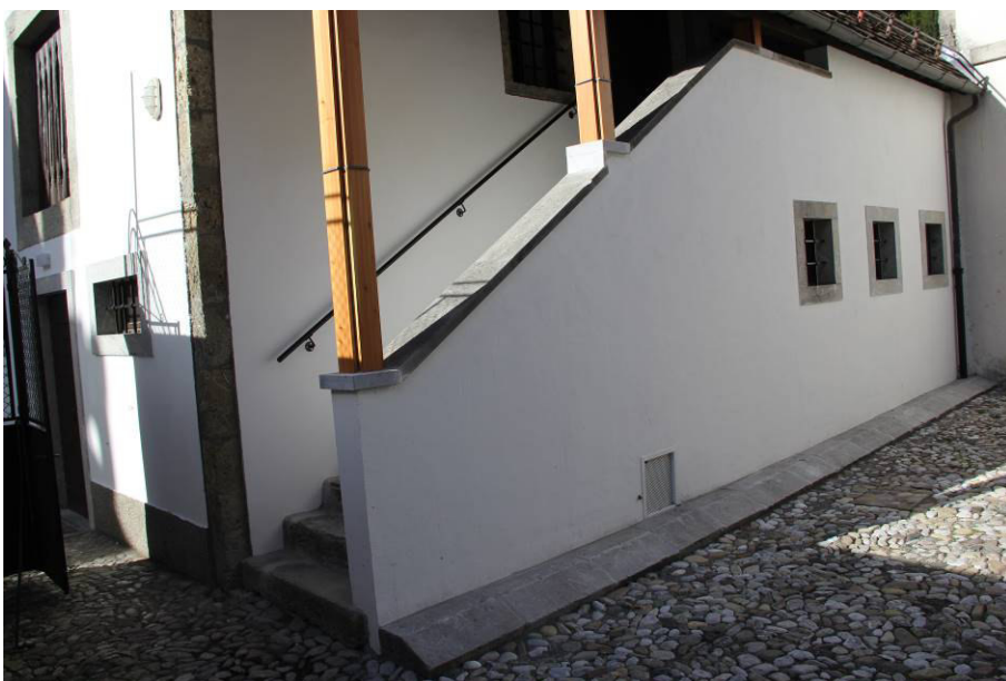
Nuova copertura scala e restauro facciata Est
