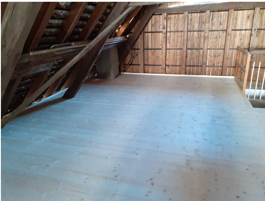
Vista dal ballatoio esterno
