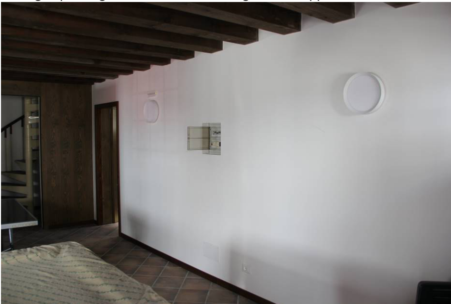
Revisione impianto elettrico e nuove plafoniere a parete
