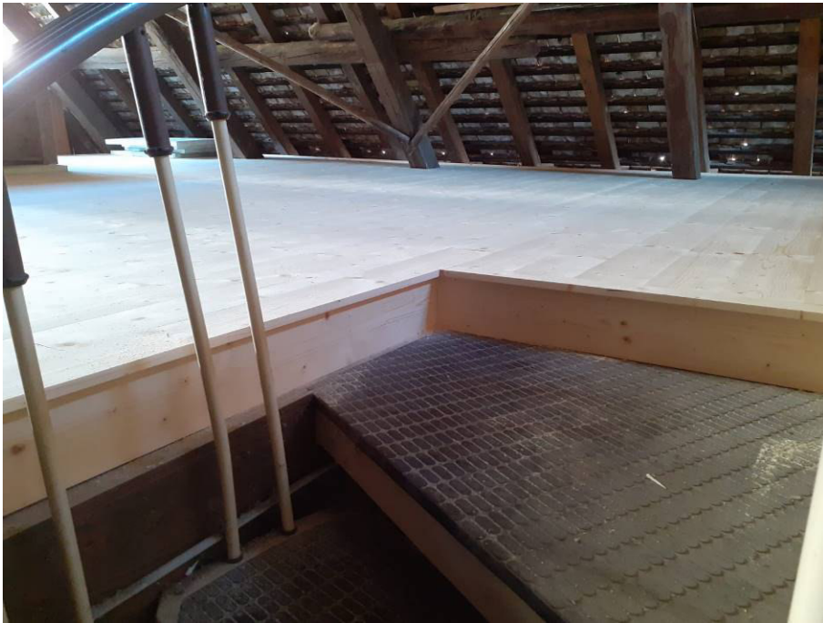
Coibentazione solaio ultimo piano con pannelli in lana di roccia solaio e posa nuovo tavolato in abete (vista dalla scala di accesso)
