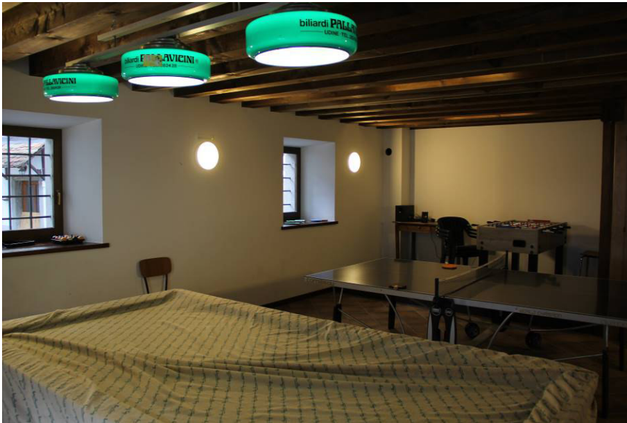
Pareti coibentate e risanate al Piano terra. Nuove plafoniere e revisione impianto elettrico
