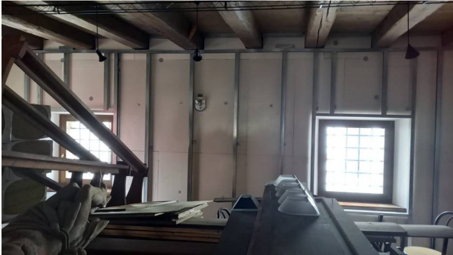
Coibentazione pareti piano primo (fase di cantiere)
