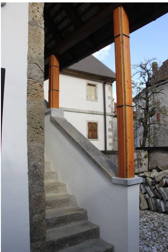
Particolare nuove colonne di sostegno del prolungamento copertura. Nuovo corrimano e stuccatura dei masselli in pietra della scala.
