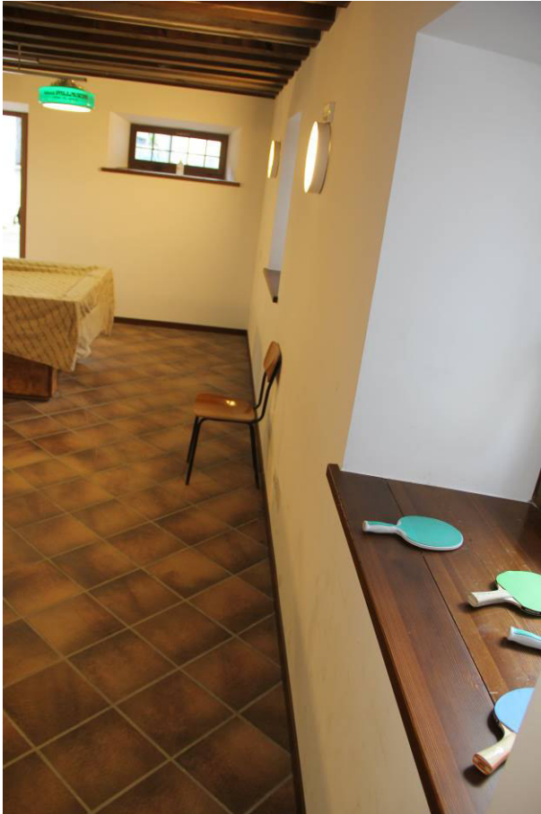
Dettaglio prolungamento avanzale a seguito dell'applicazione della contro parete
