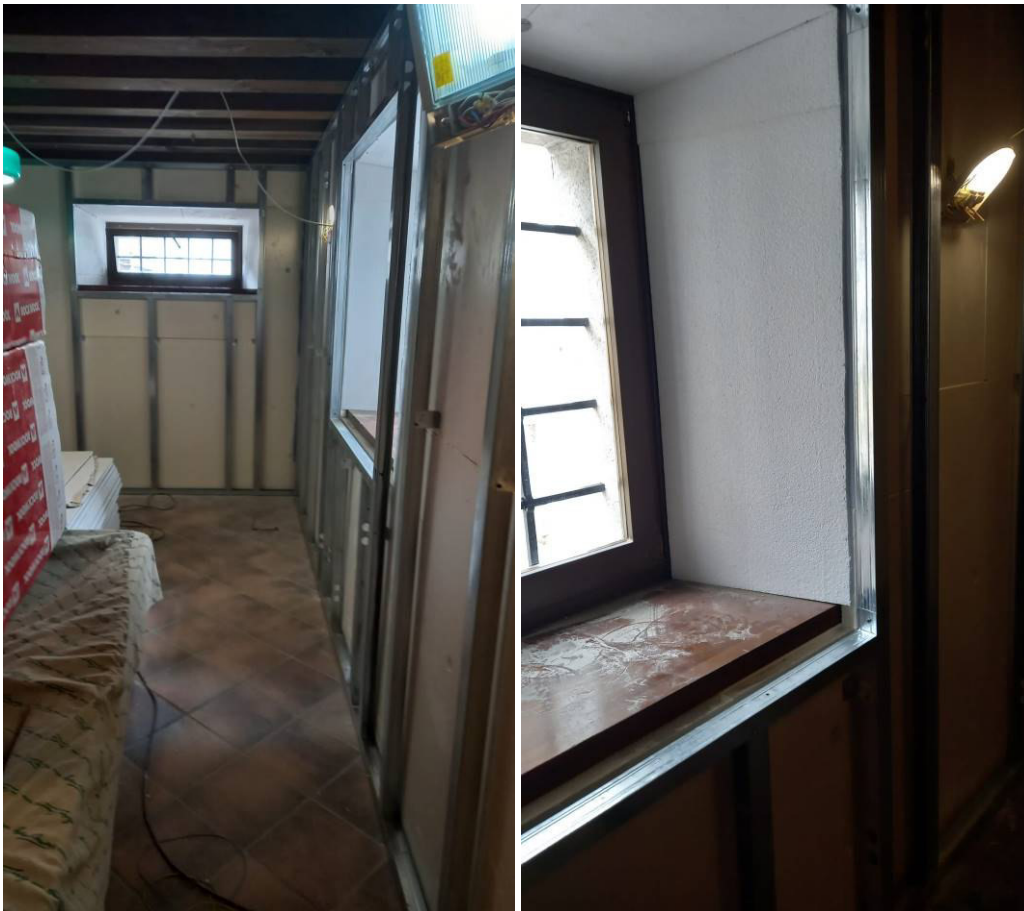
Coibentazione pareti piano terra (fase di cantiere)
