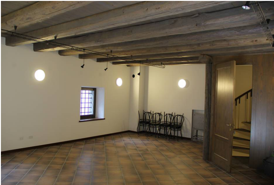
Salone al piano primo dopo le opere di coibentazione
