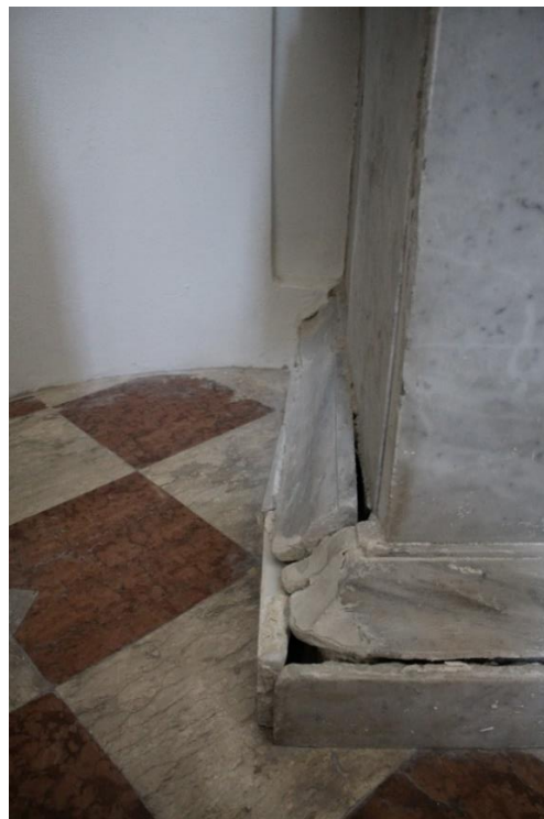
Fessurazioni e perdita di materiale nella mensa, nella predella e nella parte inferiore del paliotto. In evidenza anche la zanca della mensa che risulta arrugginita e non più ancorata.
