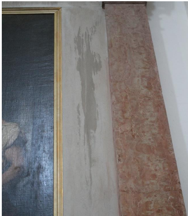
Lo stato di conservazione dell'altare: in evidenza un'alterazione superficiale dell'alzata
