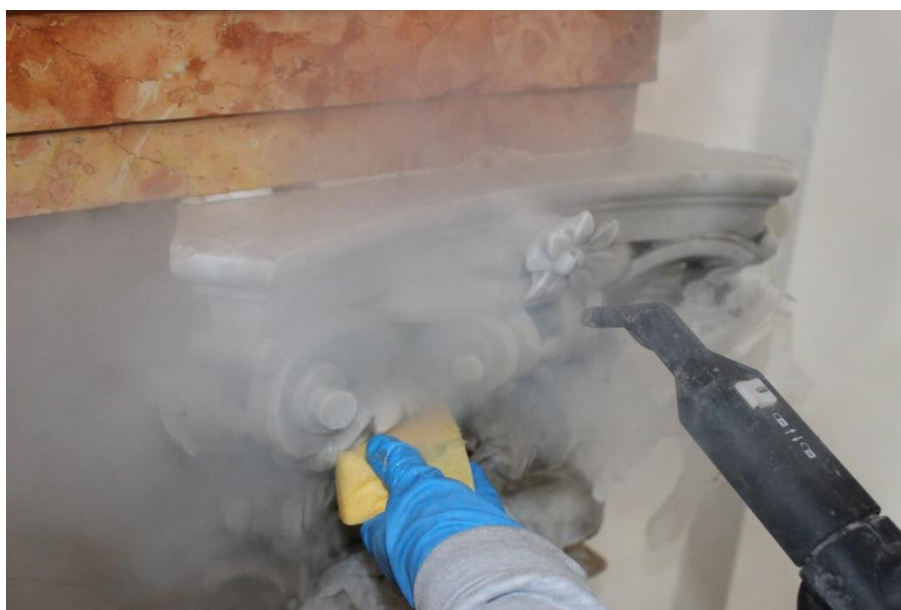
La pulitura con l'utilizzo di vaporjet dopo
