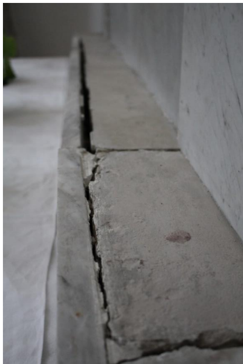
Fessurazioni e perdita di materiale nella mensa, nella predella e nella parte inferiore del paliotto. In evidenza anche la zanca della mensa che risulta arrugginita e non più ancorata.
