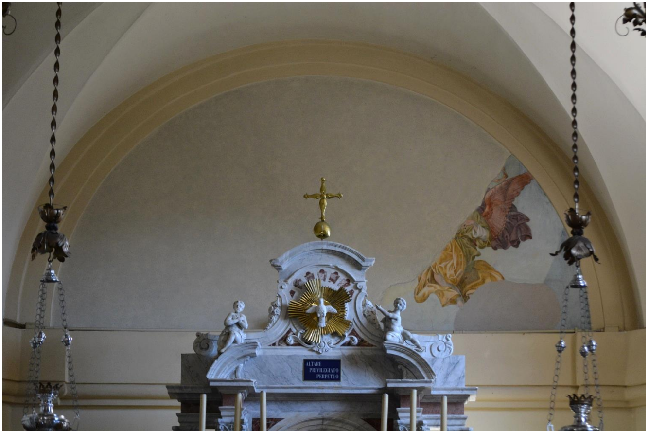
Figura 1 Stato della lunetta prima dei lavori
