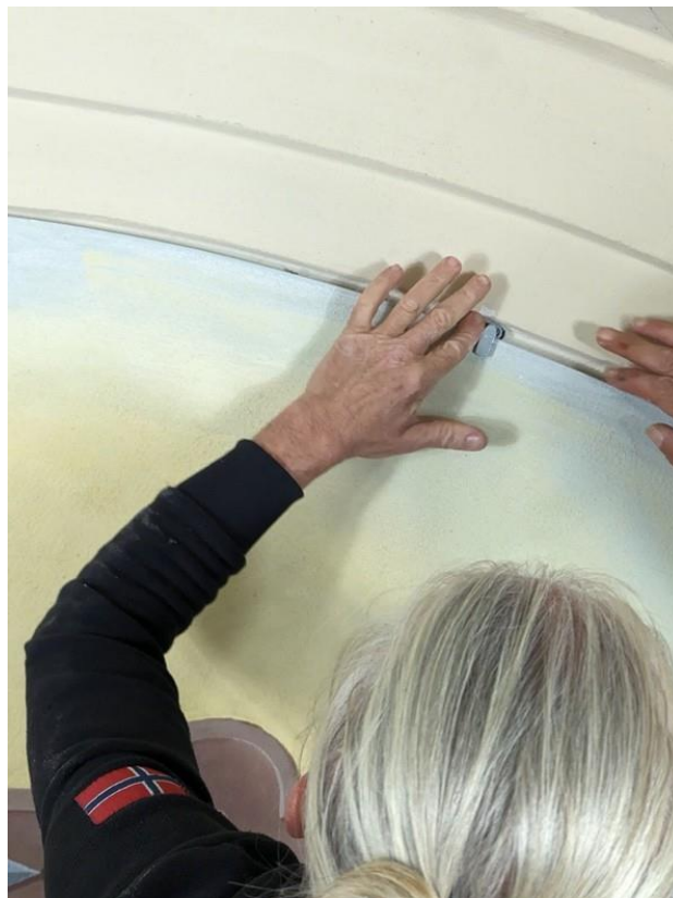
Figura 23 Posizionamento delle zanche di fissaggio
