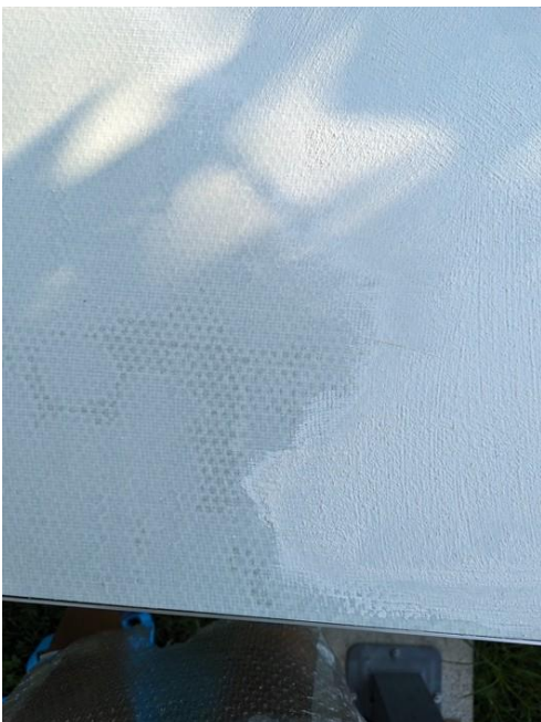
Figura 2 Stesura malta aggrappante ai silicati
