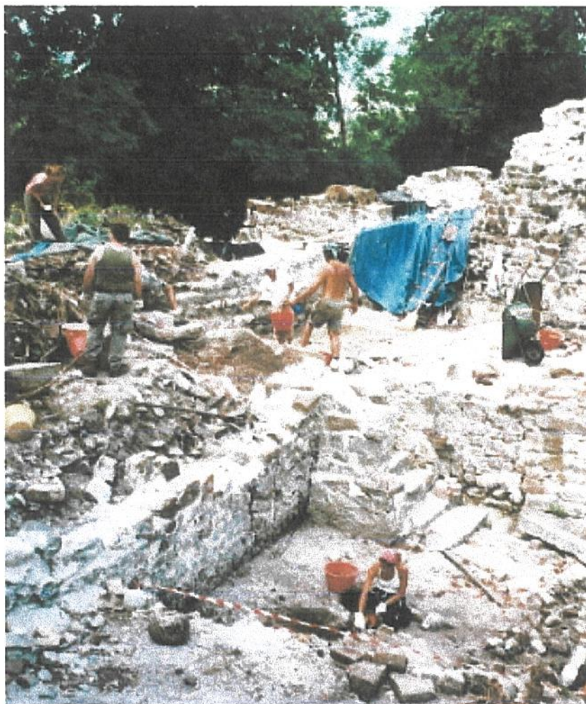
Panoramica durante i lavori dell'estate 2003
