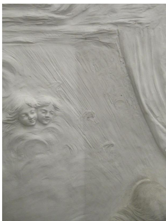
Tasselli di pulitura che mettono a confronto l'area pulita con quella adiacente, non ancora trattata.
