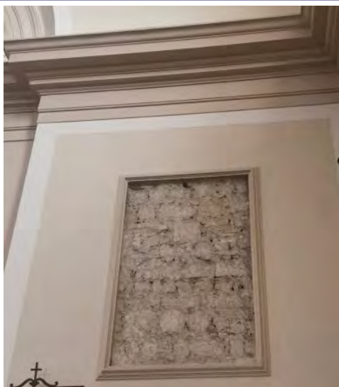
Cornice in stucco sede di collocazione del dipinto prima e dopo la pulitura e il livellamento delle fughe
