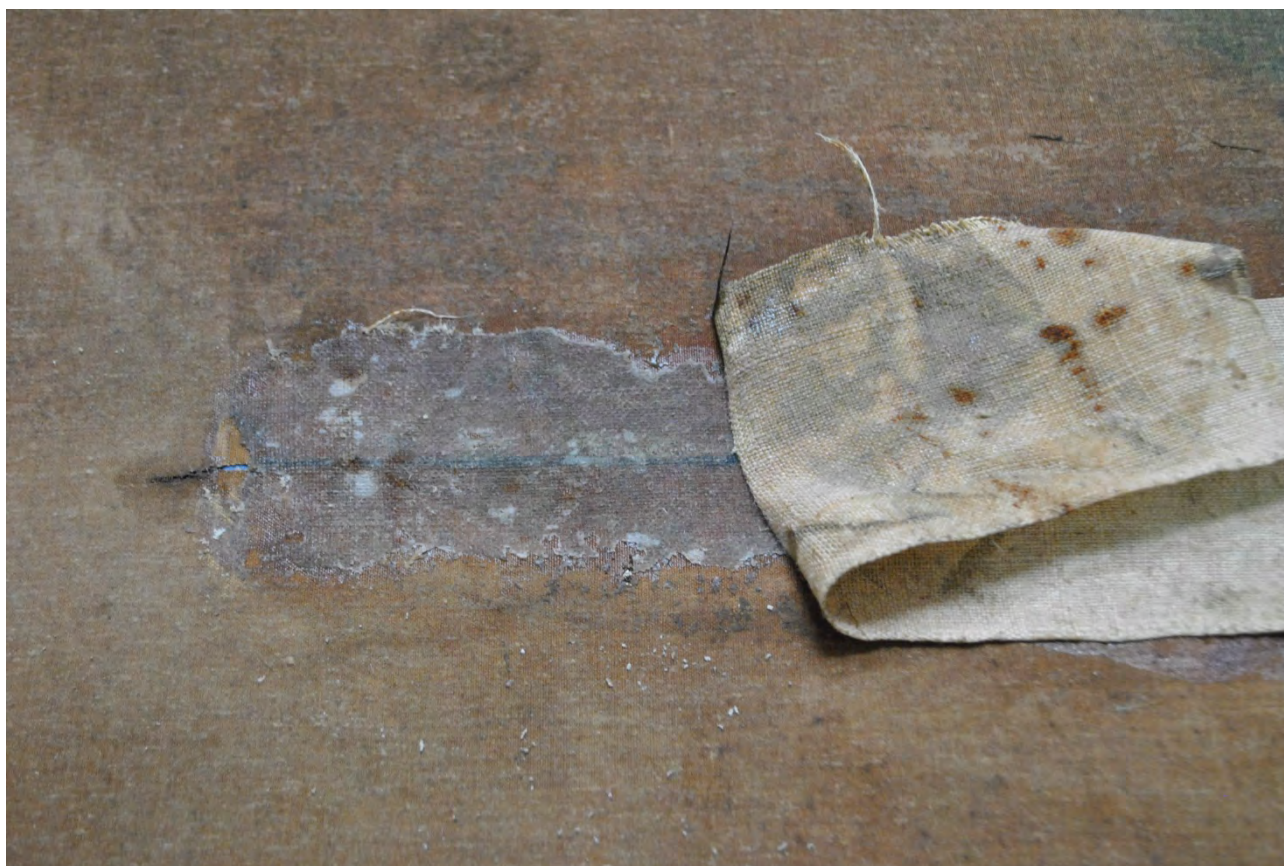
RIMOZIONE A SECCO DELLE TOPPE
