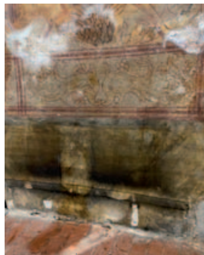
L'interno prima del restauro
