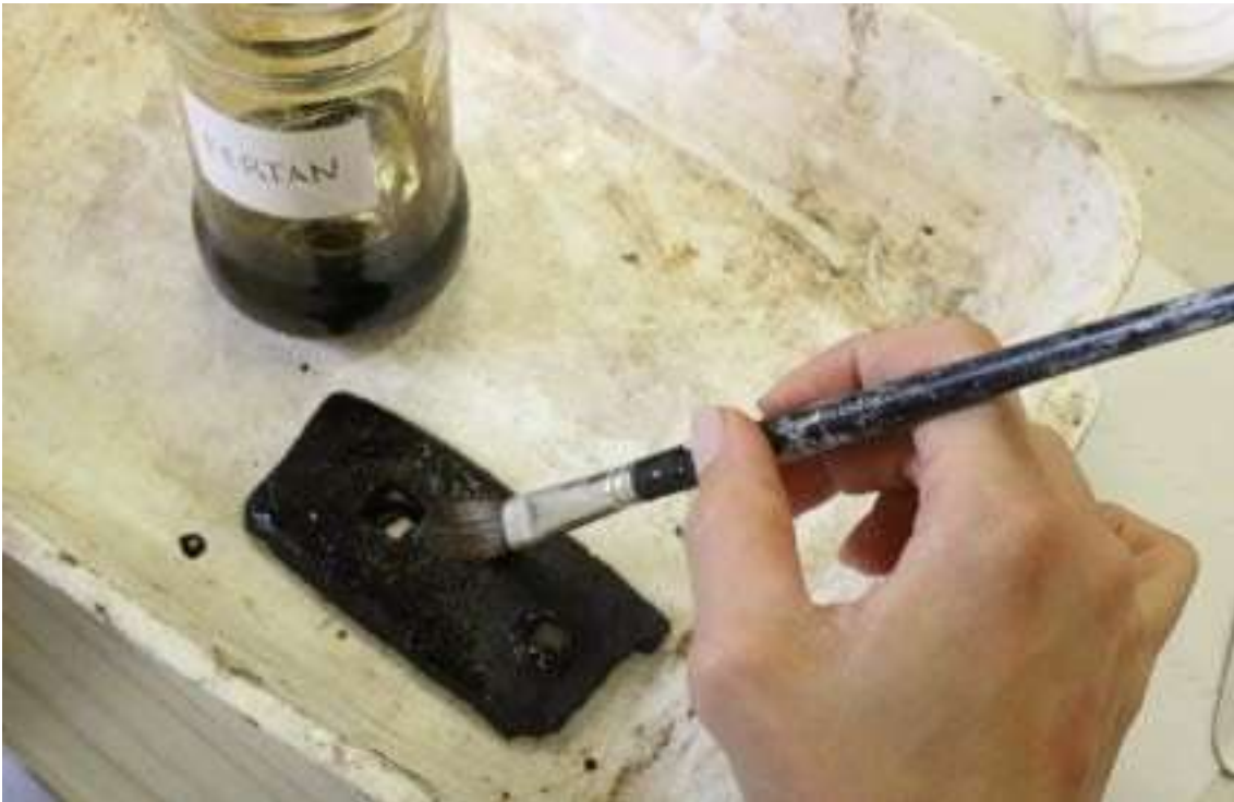
Applicazione del convertitore di corrosione
